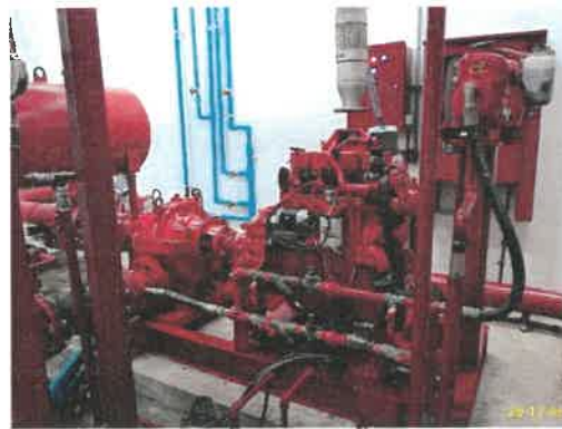
เครื่องสูบน้ำดับเพลิงชั้นดาดฟ้า
