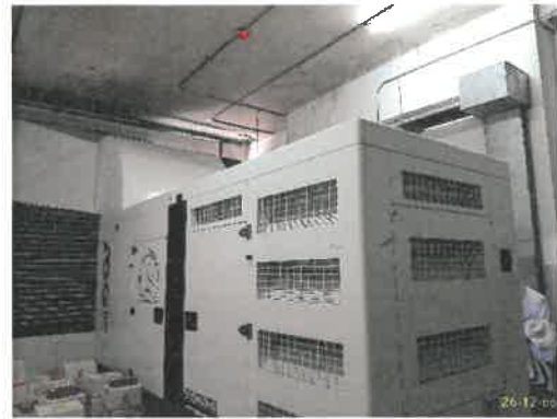
ตู้ครอบเครื่องกำเนิดไฟฟ้าสำรอง
